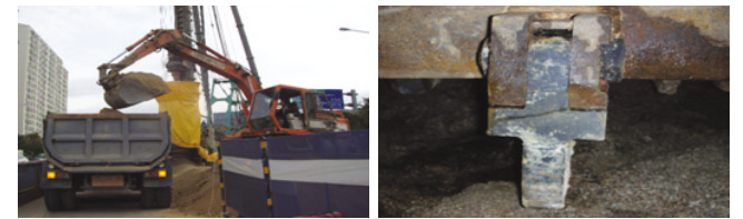
지상부 천공 전경
