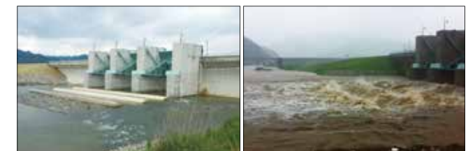
〈그림 9〉 제수문 시공현황 및 태풍 볼라벤(2012.9) 집중호우 시 감쇄현황
