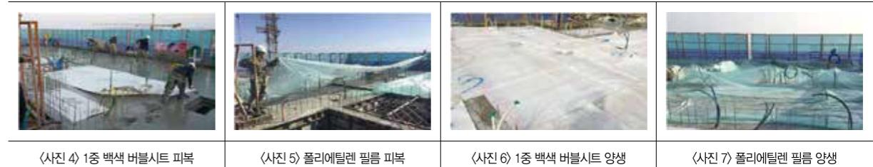
〈사진 4〉 1층 백색 버블시트 피복     〈사진 5〉 폴리에틸렌 필름 피복     〈사진 6〉 1층 백색 버블시트 양생     〈사진 7〉 폴리에틸렌 필름 양생
